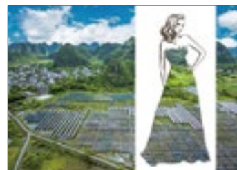
廣西省上林協鑫 60 兆瓦光伏電站
