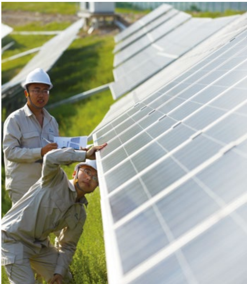
▲ 山西黎城電站光伏組件檢修
