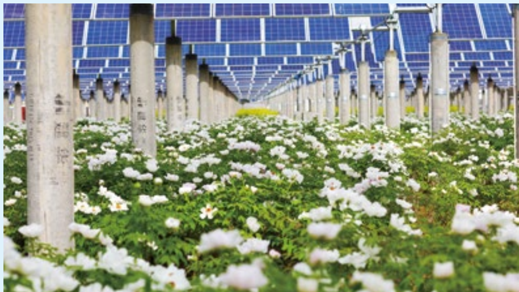
▲ 位於宿州的 40 兆瓦「光伏 + 牡丹」電站
